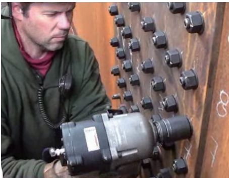
图 15 超声波智能螺栓及拧紧示意
